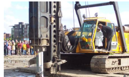
De eerste heipaal voor Carnisse Haven wordt geslagen.
